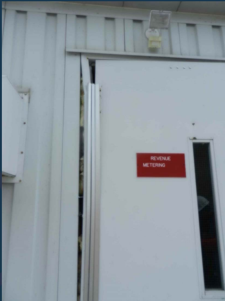
Broken Door Jamb
